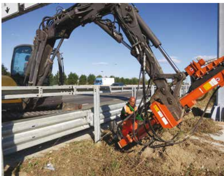
14. Una fase di Installazione di S.C.Re.W.S
