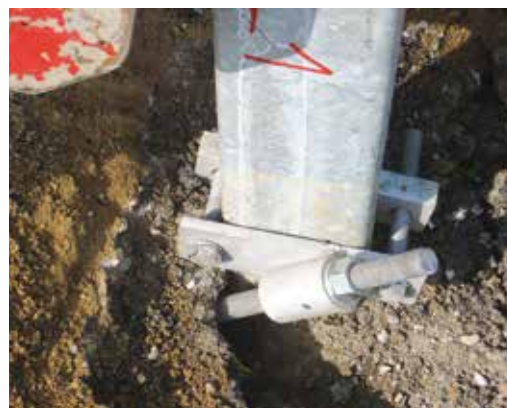
15. Un dettaglio del montante della cravatta di fissaggio dello S.C.Re.W.S.
