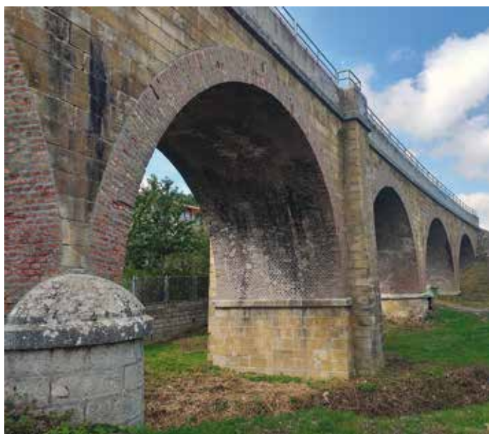
9. Esempio di ponte ad archi in muratura
