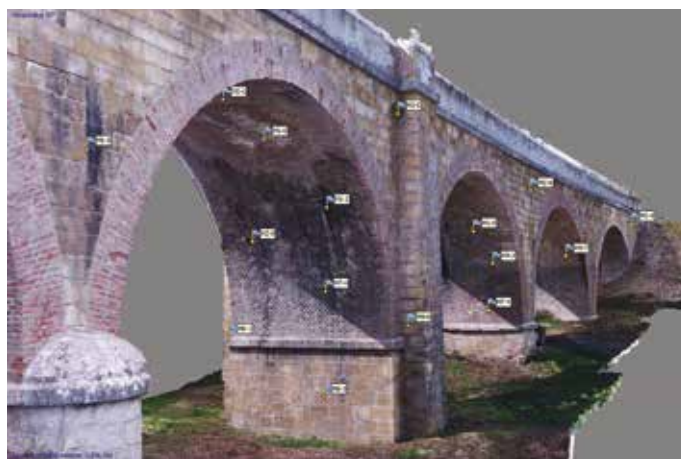
11. Esempio di inserimento marker difetti modello 3D
