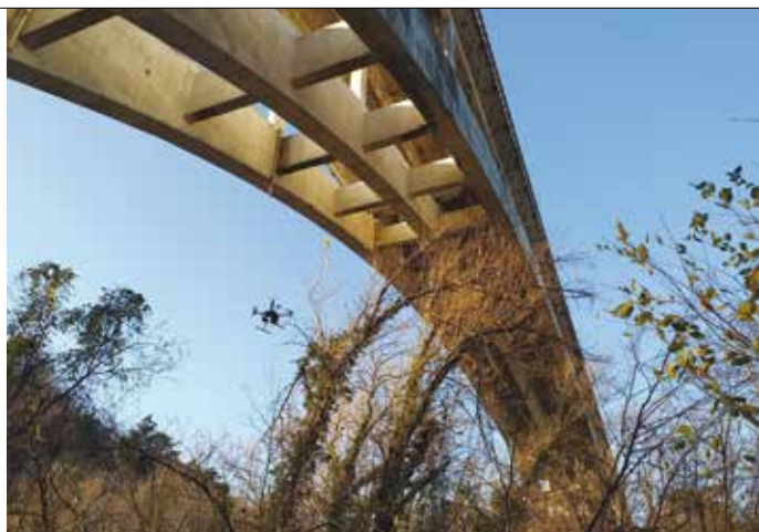
2. Esempio di ispezione con drone
